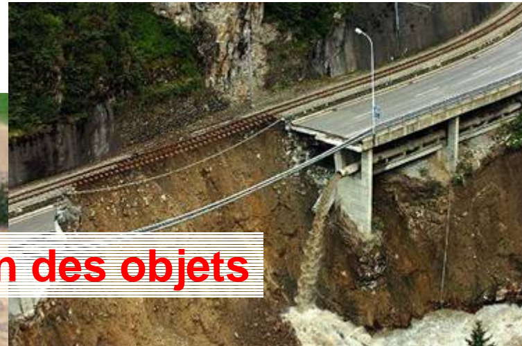
Voies de communication
