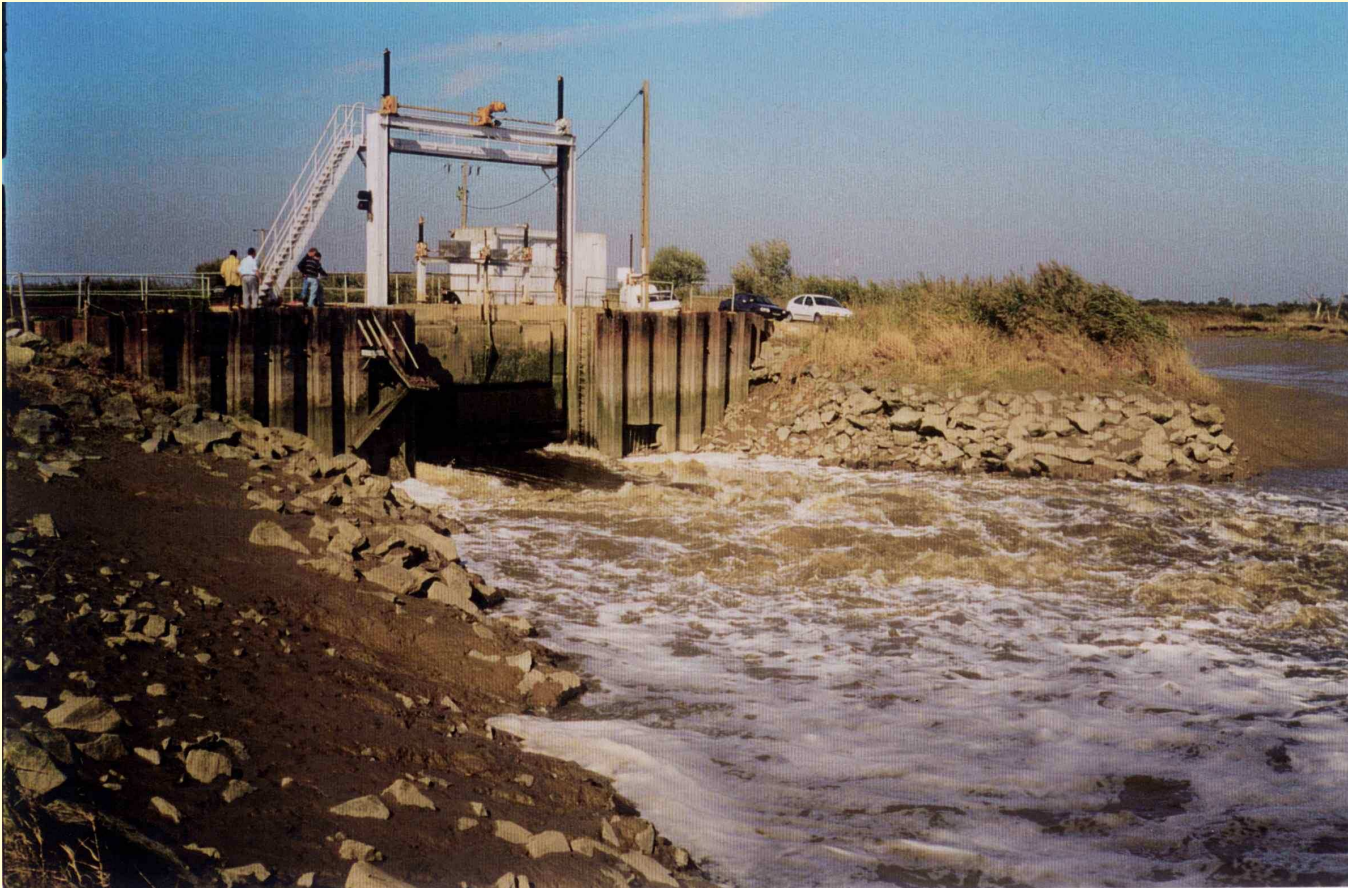
Vannage de LAVAU (44) Vue général aval
