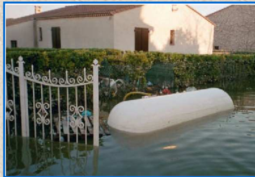
Arrimage de citerne à combustible
