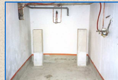
Cuvelage de cave
