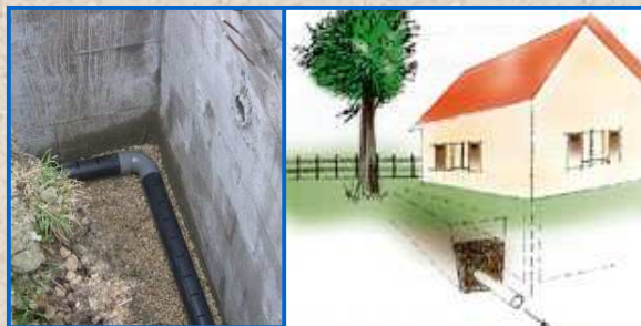
Drains de fondation
